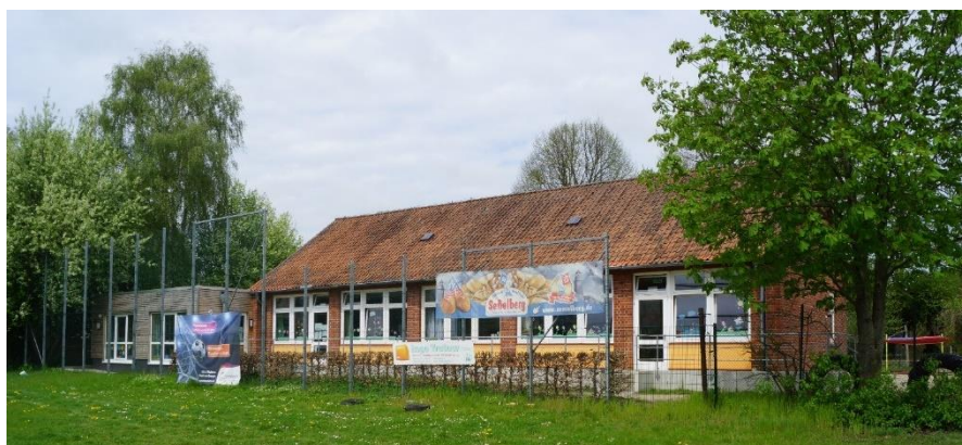
Abbildung 21: Kindergarten Altenkrempe (CIMA 2021)
